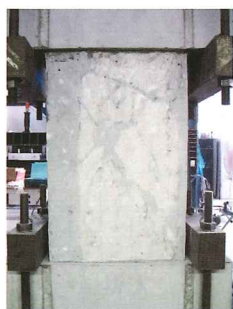
4 補修完了状況 注入完了後、表面研磨 (AC-1RE)
