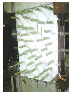
3 エポキシ樹脂注入状況 使用材料: E-396H IPHカプセル: 注入圧力0.06N/mm 2
