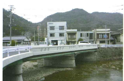
6 完成 (橋梁全体)
