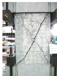
6 せん断破壊試験後状況(補修後) ※せん断破壊は注入位置ではなく、オリジナルコンクリート部で発生
