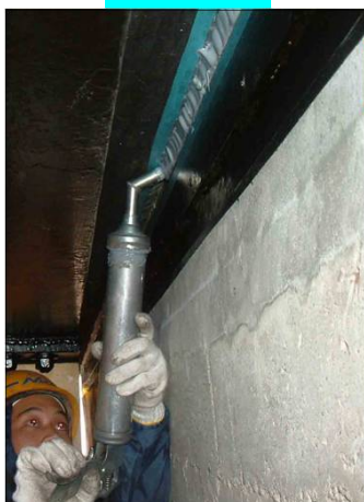
⑦下面・地覆端部コーキング処理
