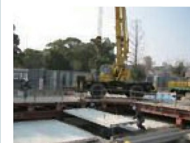
⑥プレキャストスラブ材の布設
