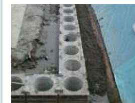
②PC-壁体施工完了
