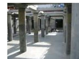
⑤底板コンクリート打設
