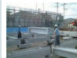
③プレキャスト梁部材の設置
