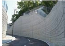
コンクリート打設仕上
