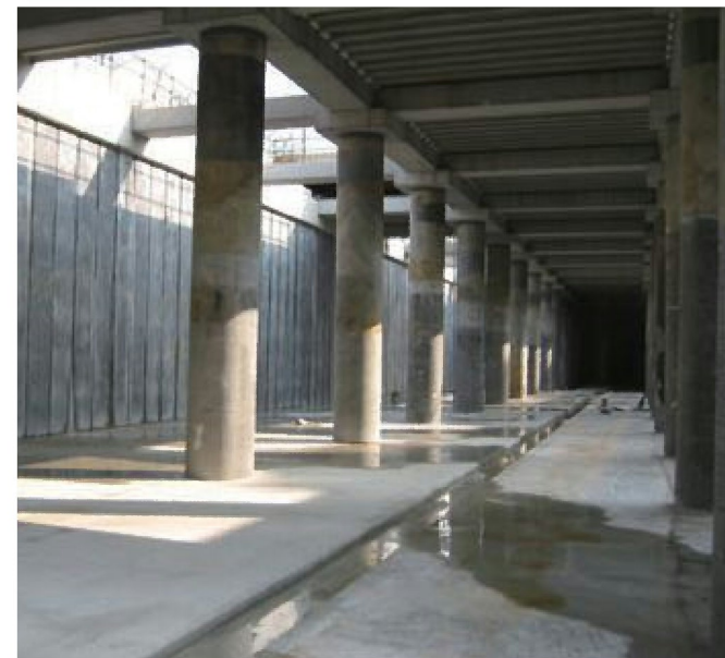
①PC-壁体・中柱の施工
