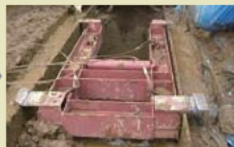
PC-壁体建込用定規の設置
