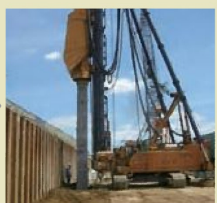
下部材の沈設
