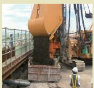
排土ホッパーからの土の搬出
