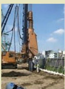
上部材の沈設
