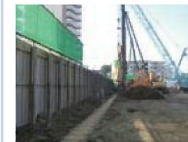
①PC-壁体・中柱の施工
