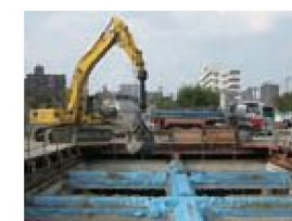
④内部掘削
