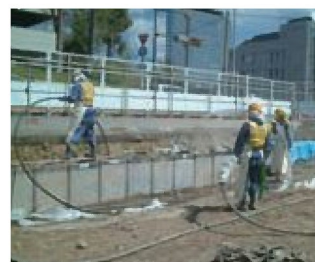
モルタル注入
