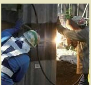
上部材の建込み・継手溶接
