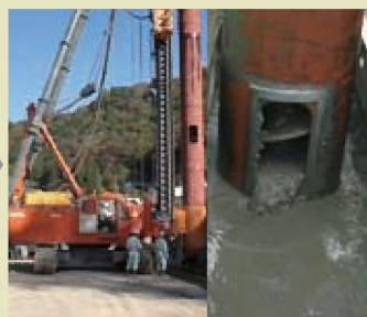
プレボーリング削孔・セメントミルク注入
