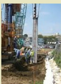
下部材の建込み
