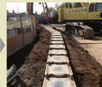
PC-壁体の沈設完了
