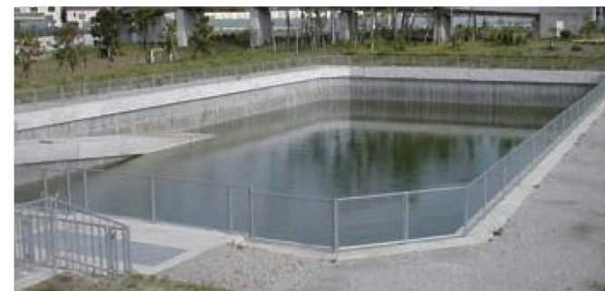
②PC-壁体施工完了
