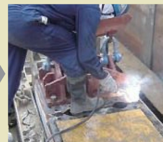
頭部連結溶接
