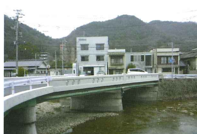
6 完成 (橋梁全体)
