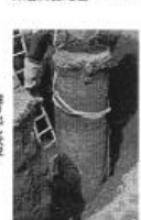
機械攪拌式深層混合処理
