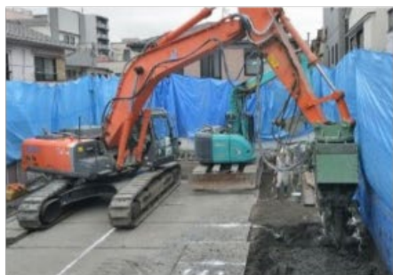
土留め壁造成
