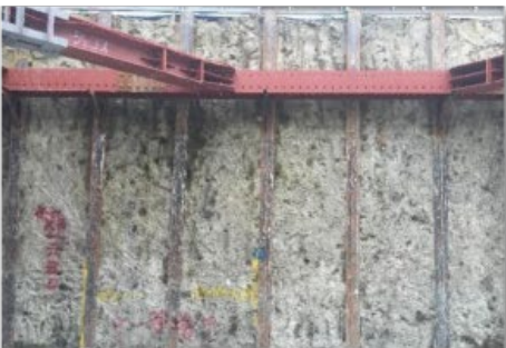
土留め壁拡大
