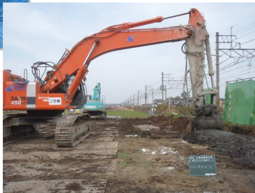
【鉄道近接施工】
