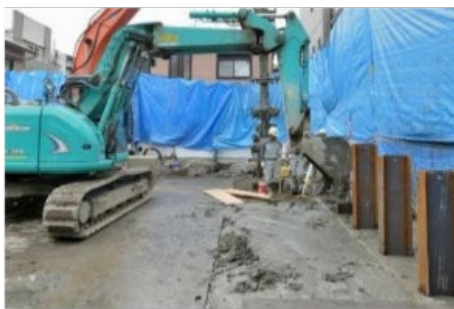
芯材(H鋼)立込み
