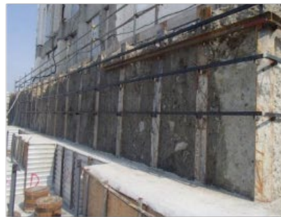
土留め壁拡大
