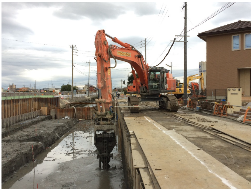
○狭隘なエリアでの段差施工状況
