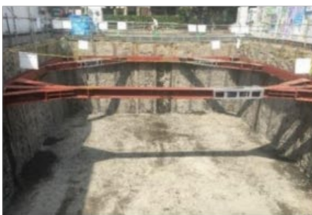
土留め壁・底板造成後、掘削完了
