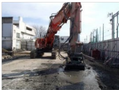
土留め壁造成
