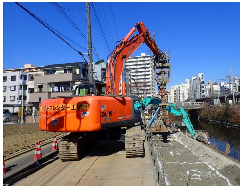
○狭隘なエリアでの段差施工状況
