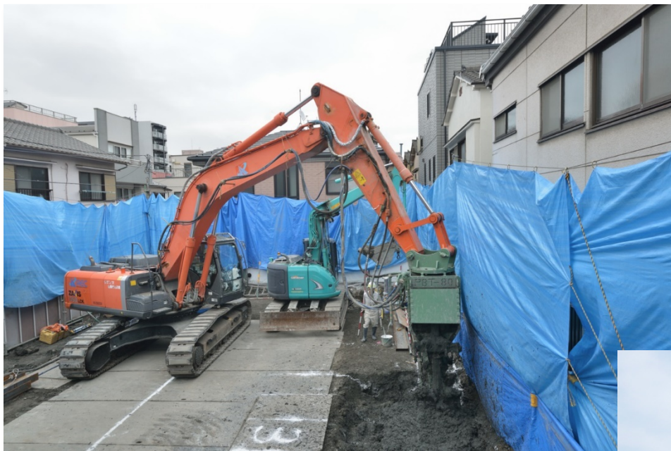
【建物近接施工】
