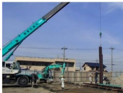
芯材(H鋼)立込み
