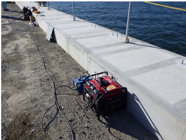
フェンス柱脚
