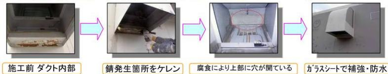
⑥ガラスシート貼り 溶接箇所及び前室と本体ジョイント部、前室天井にガラスシートを貼り防錆、防水、遮熱効果を高める。
