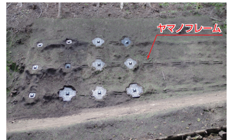
植生基盤吹付完了
