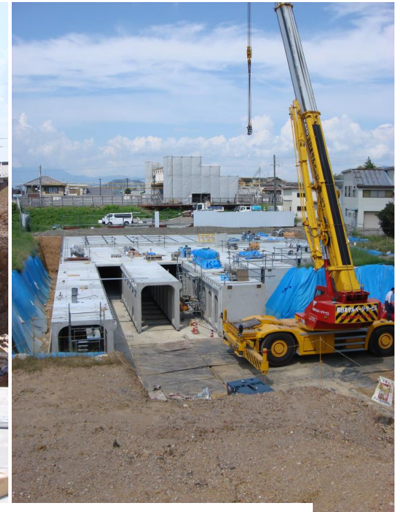
耐圧底板上にクレーンを設置した例
