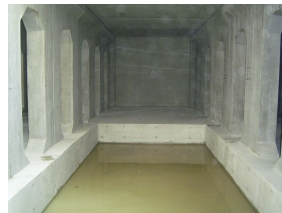
ポンプピット例
