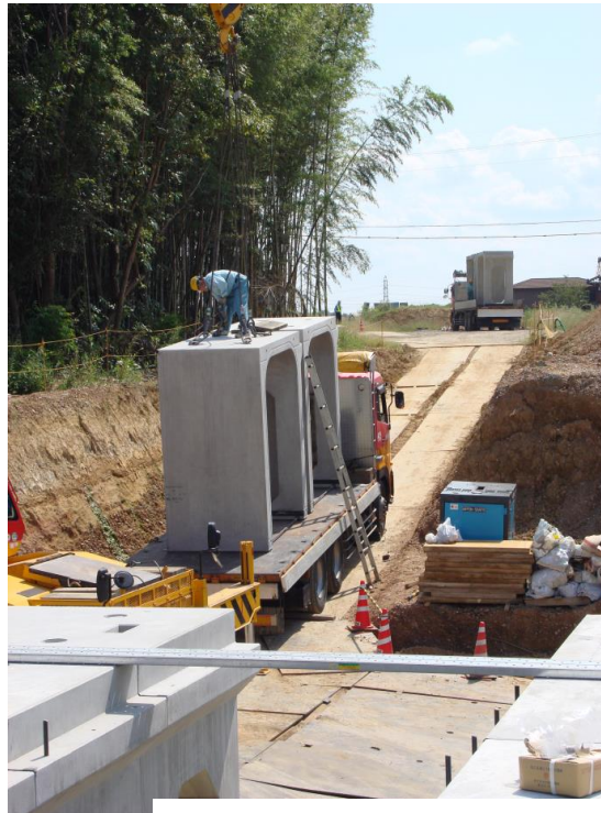
耐圧底板上にクレーンを設置した例
