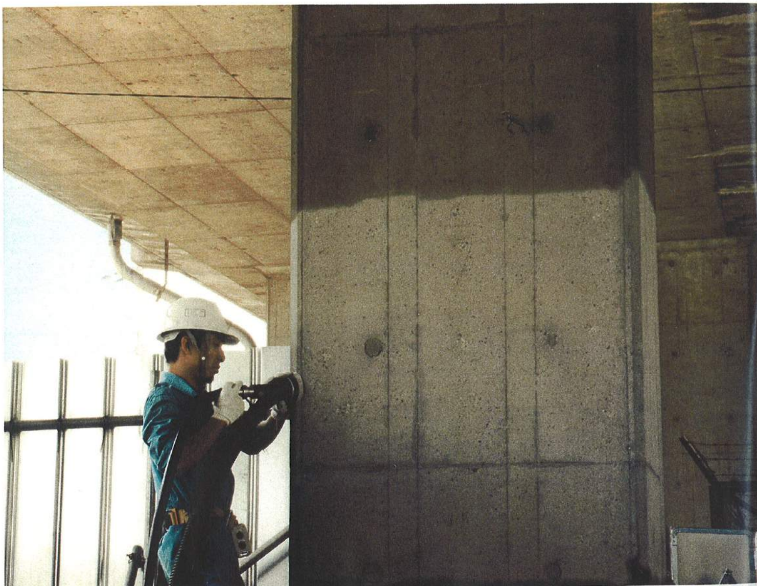
名神高速西宮工区復旧工事現場
