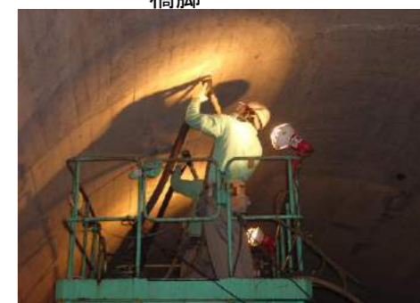
トンネル内部
