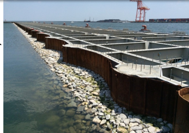
直線型鋼矢板を円弧状に打設
