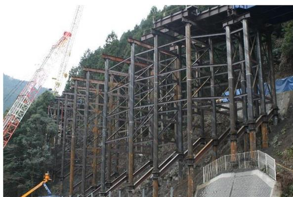
進行方向の斜材削減により工期短縮の実現！！
