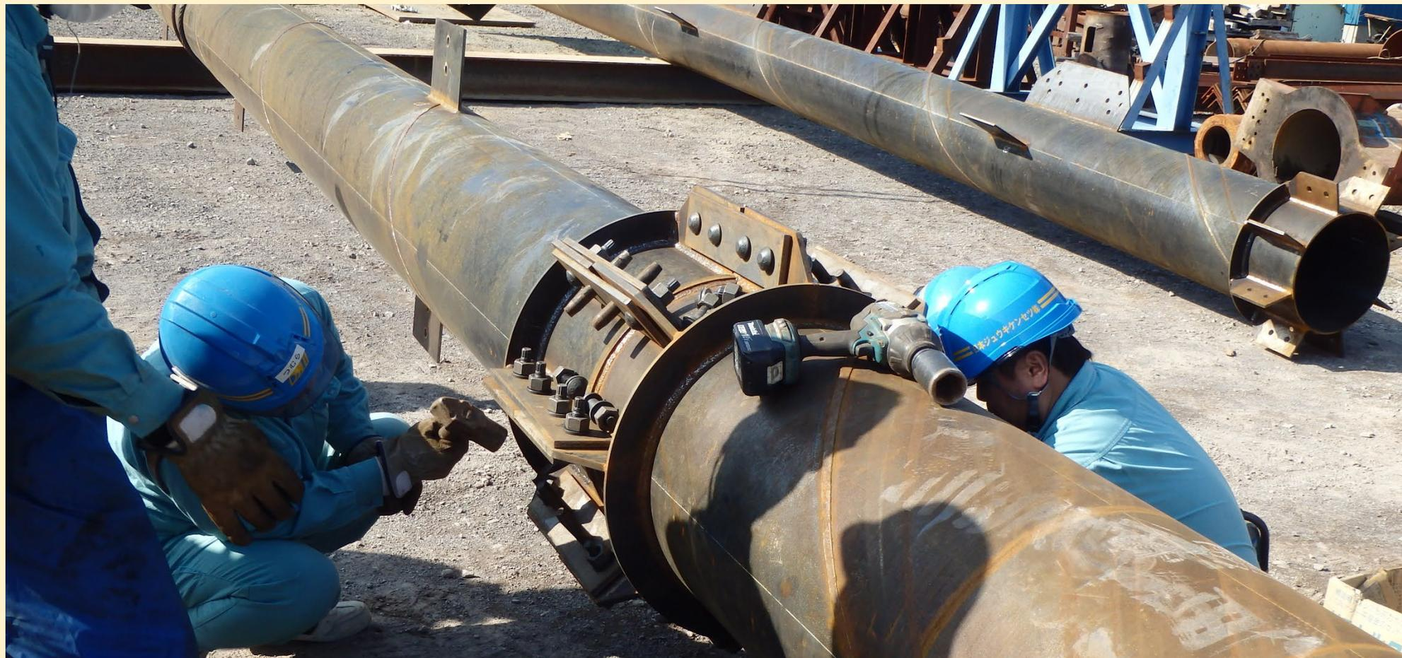
ドリフトピンを使い、パラミックス支柱のボルトの遊び間隔の調整
