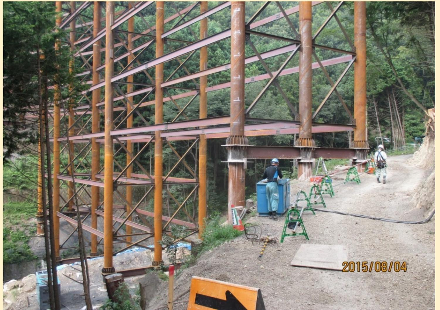
鋼管杭を採用することにより、支持杭の剛性が向上します。ブレス等の設置段数が減少でき、また、杭の本数も減少したため経済性の向上にも繋がります。
