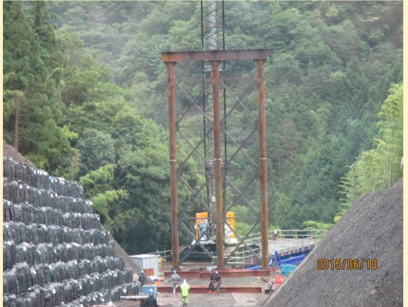
支柱杭とブレス等は仮橋上で地組を行い、パネル状にて基礎梁に設置するため高所作業が激減し、安全性が向上します。
