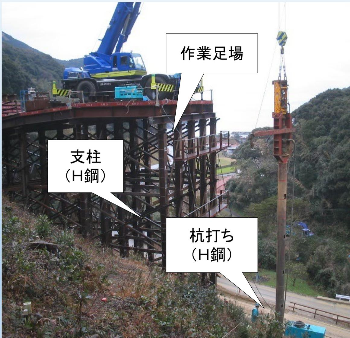
しかし、仮栈橋の栈橋高さの上昇・高所での水平材・斜材取り付け時の危険・仮栈橋のスパン長の増加等に伴うクレーンの大型化等の問題が発生しています。
