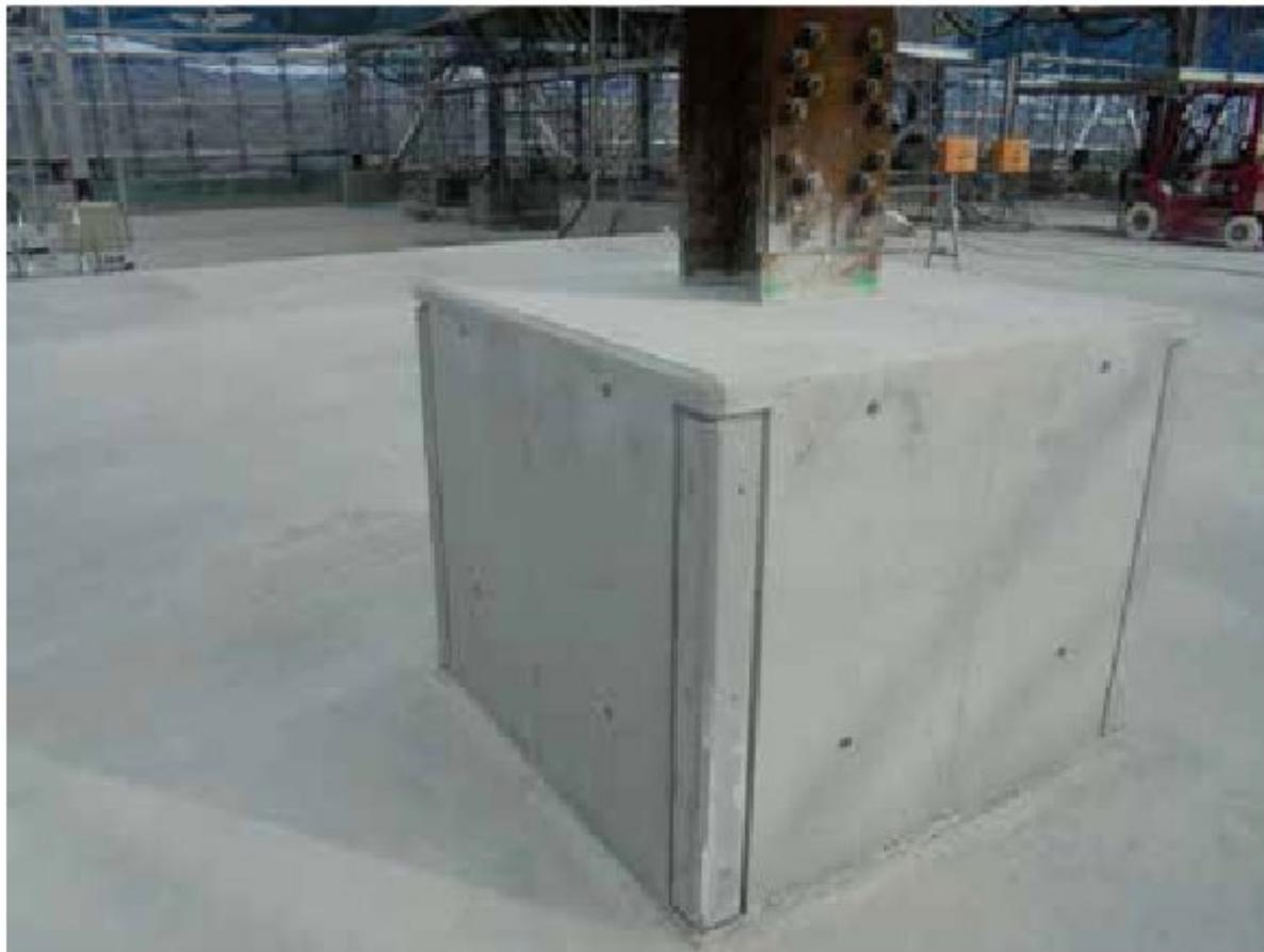
物流倉庫：鉄骨柱根巻（脱型後）
