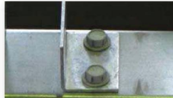
⑥締め付け完了
