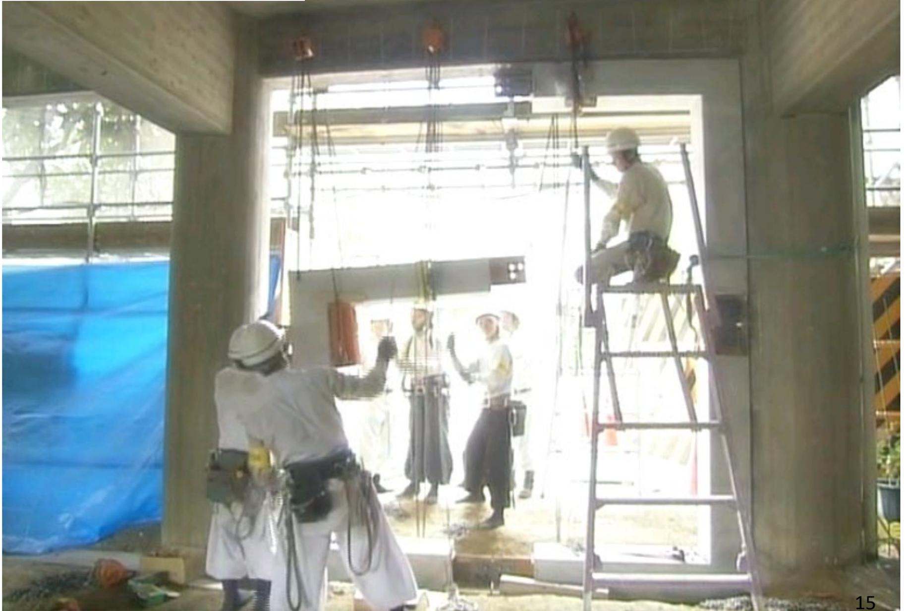
アンカー固着。調整・ボルト本締め
