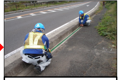
③ 養生テープ貼付
