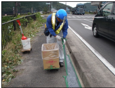
⑦ 養生テープ撤去
