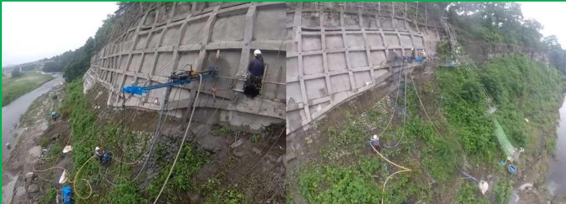
世界遺産施設保全／最難度現場での排水ボーリング。次元の違う世界最高性能
