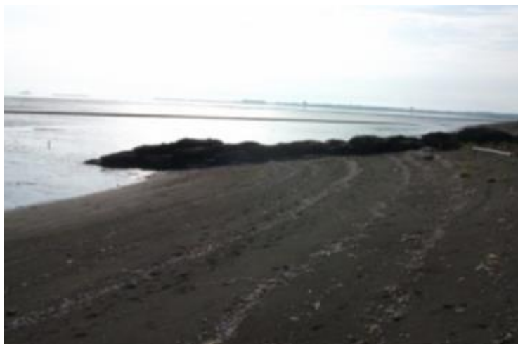
突堤の吸出し防止材 (大分県中津土木事務所)
