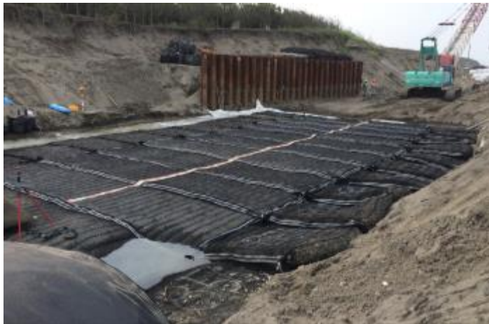
埋設護岸工の洗掘防止材 (国土交通省宮崎河川国道事務所)
