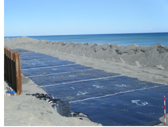
アスファルト系マット 高重量ではあるが透水性がない
