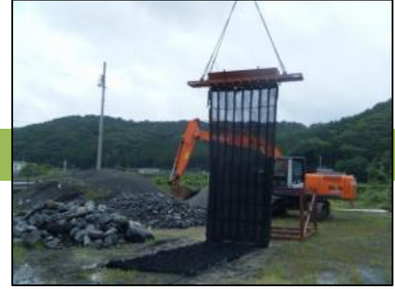
③一定量を投入したら、吊上げる。 ②～③を繰り返す。
