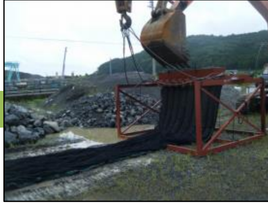
②バックホウで中詰め材を投入する
