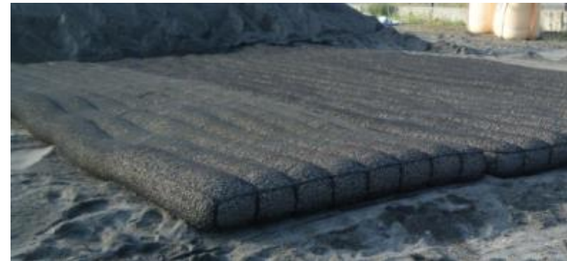
セル型グラベルマット 高重量かつ透水性良好
