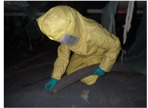
エコクリーンクールスーツ着用 による研削材+塗装カス回収状況
