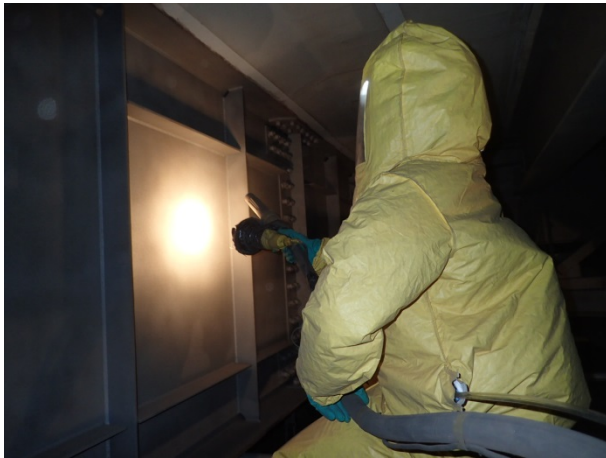
エコクリーンクールスーツ着用 によるブラスト作業状況
