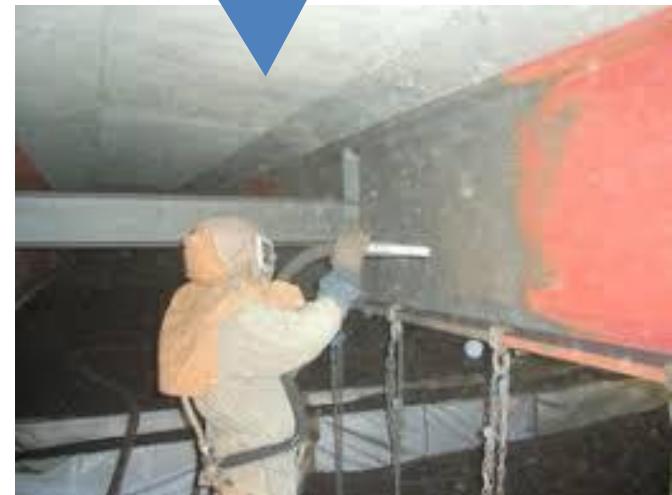
送気マスク装備でのブラスト作業状況
