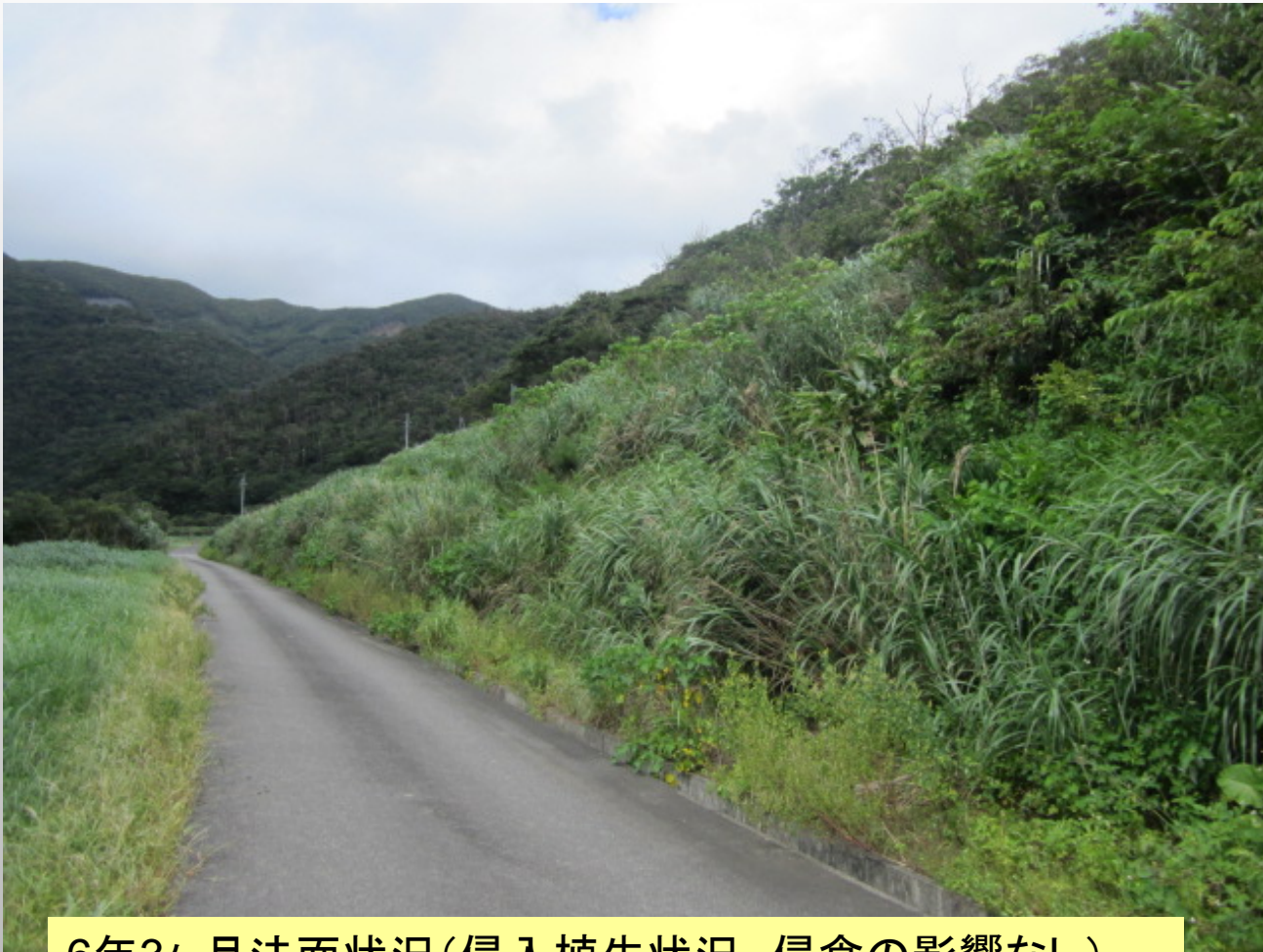
6年3ヶ月法面状況(侵入植生状況, 侵食の影響なし)
