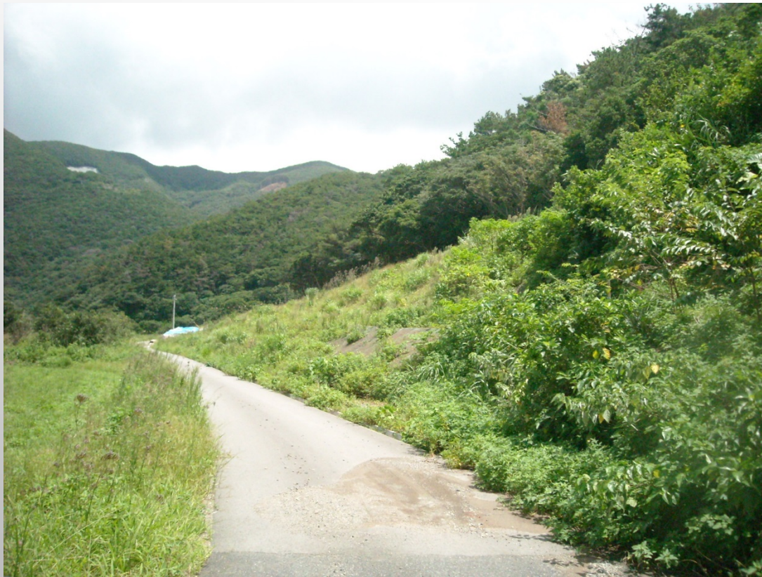
1年5ヶ月法面状況(法面浸食の影響無し)
