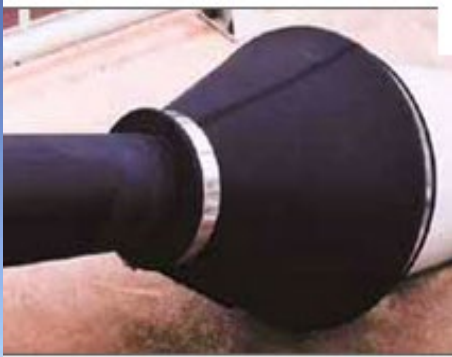
斜張橋ケーブル ゴムカバー表面
