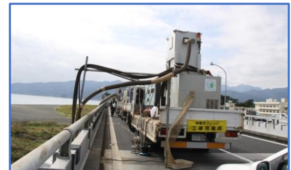
車載式による 橋面からの施工例
