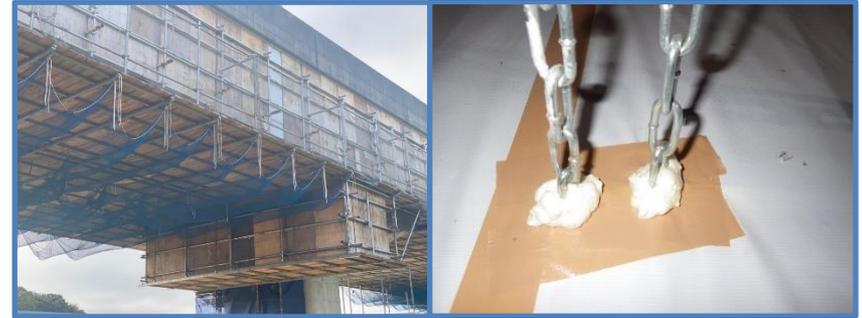
↑ブラスト作業は、研削材や塗膜くず等の飛散防止のため、足場周りを板張り防護設備等により作業エリアを密封し、内側からも隙間を塞ぎ、負圧集塵装置により作業エリア内を負圧に保つ必要がある。
