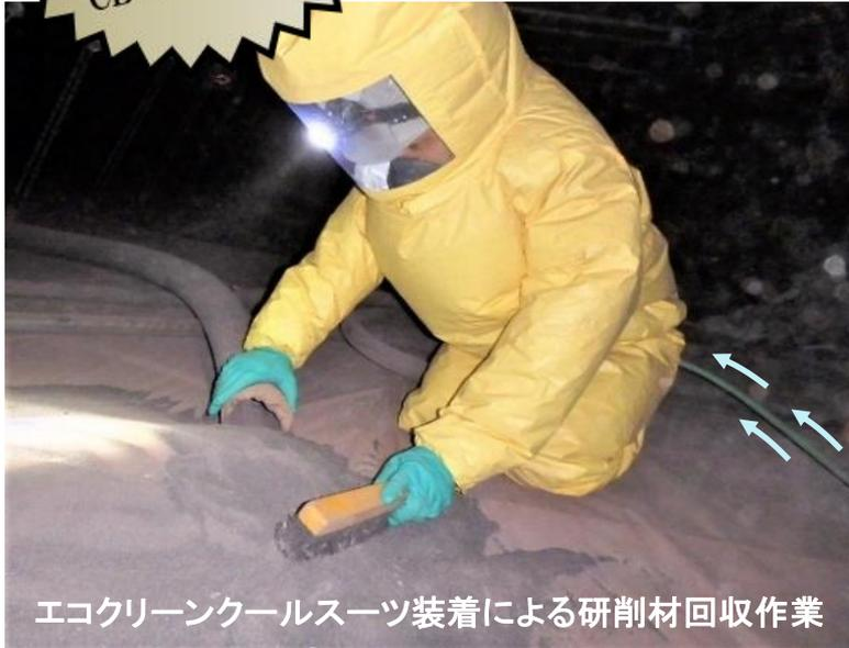
エコクリーンクールスーツ装着による研削材回収作業
