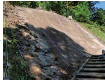
▲ 崩壊した部分を除去し、改良土吹付で間詰め処理を実施。断面復旧した表面部にGTフレーム工法を施工。
