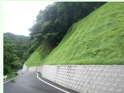
地山補強土工（ロックボルト工）併用タイプ
