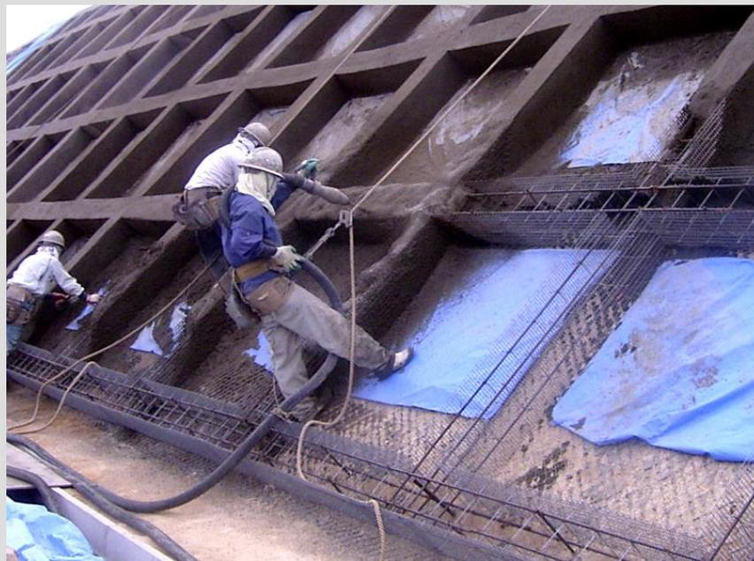
モルタル材は、緑化の妨げになるため、枠内のシート養生およびリバウンド材の廃棄物処理が必要
