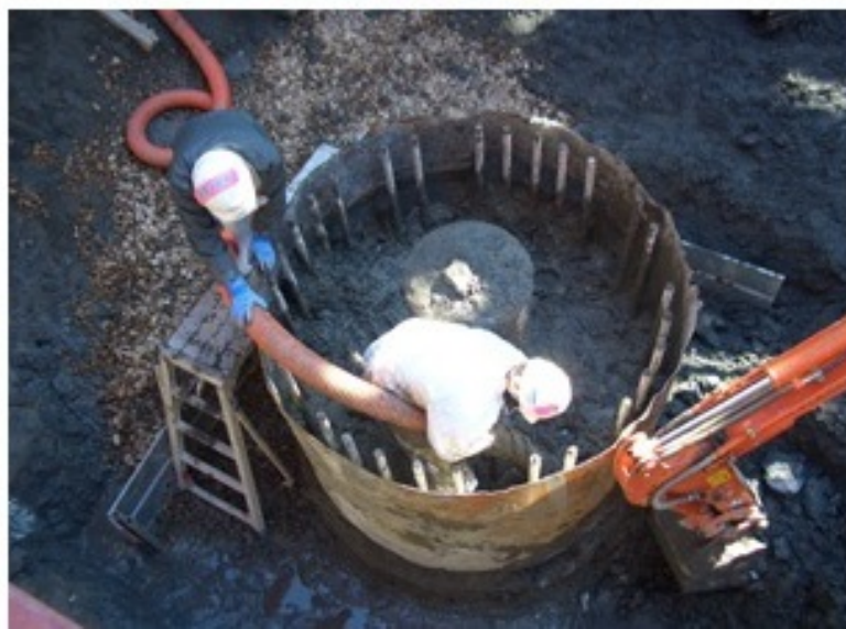
市民病院 杭頭スライム吸引
