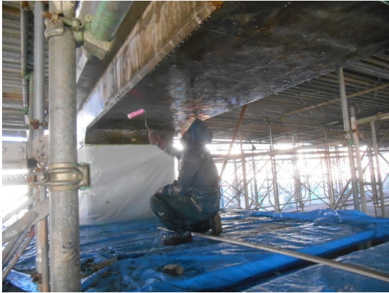
ローラーによる施工
