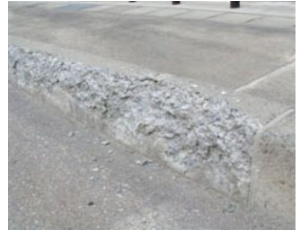
凍害によるスケーリング
