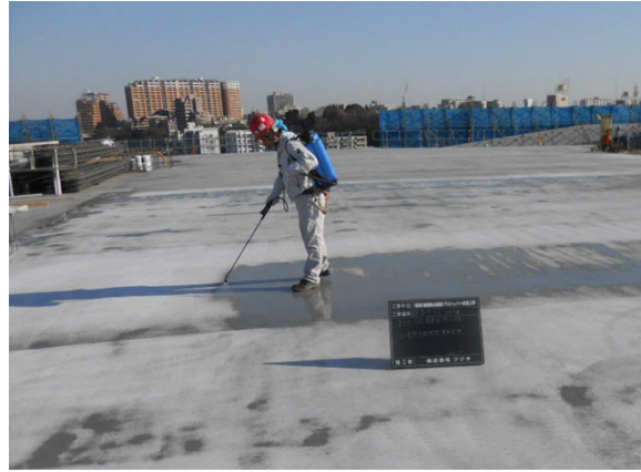
噴霧器による施工
