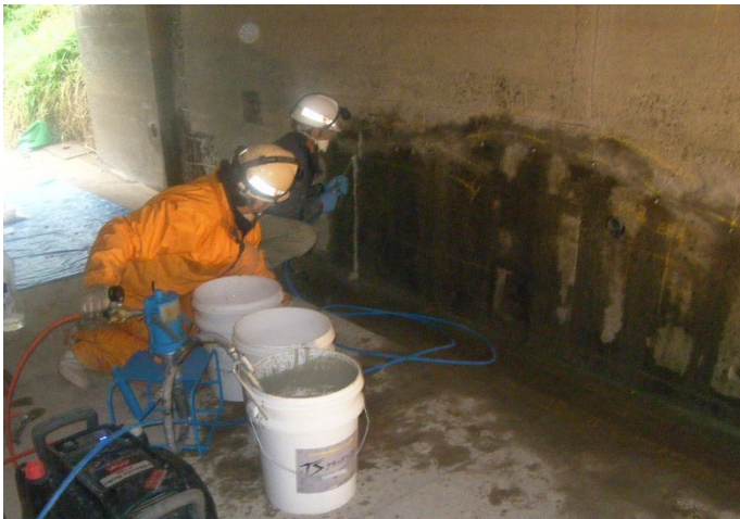
無機系注入工法
