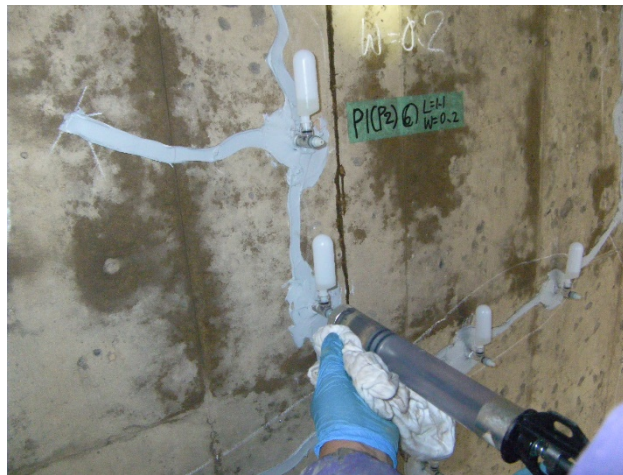
樹脂系注入工法
