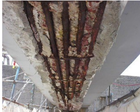
塩害によるかぶりの損傷
