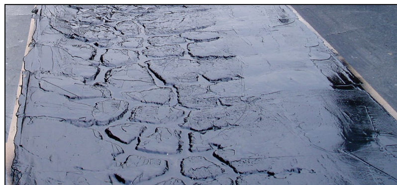
溶かしたラバファルトを流し込んだ補修箇所
