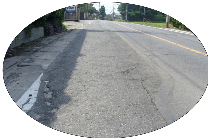
平成18年11月施工 平成23年8月撮影 施工後約4年9ヶ月
