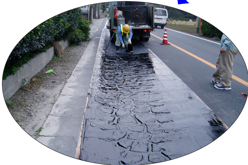
舗装の可動を制御、残舗装の再生
