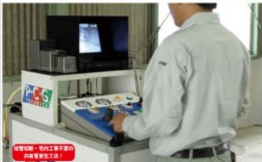
管内カメラで確認して分岐部枝削孔とライニング加工
