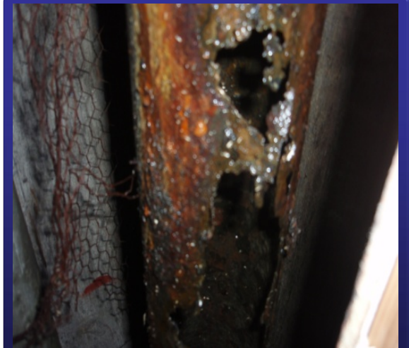
【たて管腐食部分】
