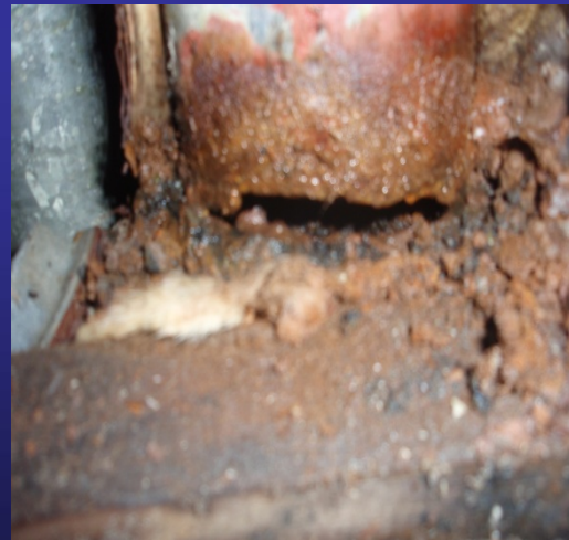
【たて管スラブより腐食】
