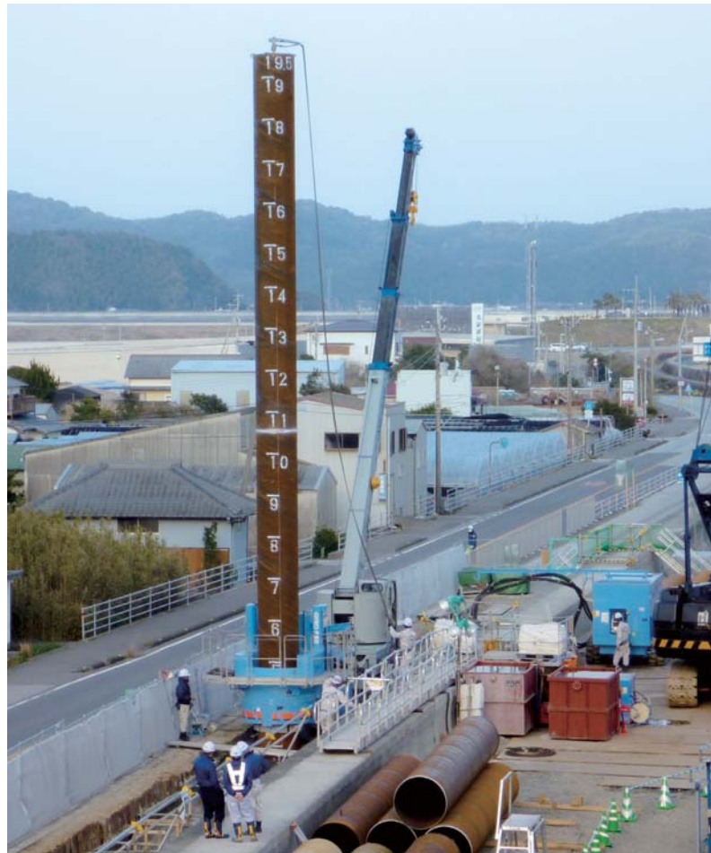
現況交通に影響を与えず鋼管杭圧入 (ジャイロプレス工法)
