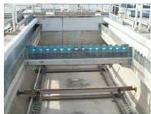
最初洗設池改修防食工竣工
