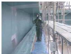
スプレー工法トップ塗布状況
