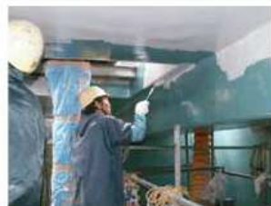
汚泥貯留槽改修防食工 ローラー塗布状況
